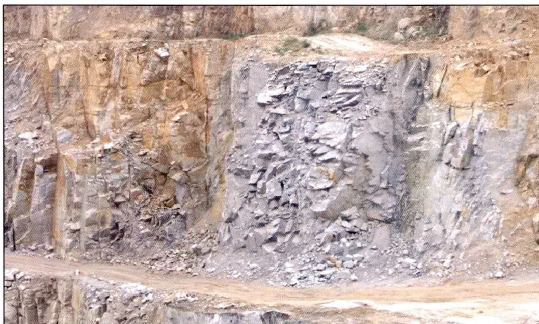
Foto 2 - Aspecto de um talude vertical situado num dos patamares do fosso de exploração principal.
