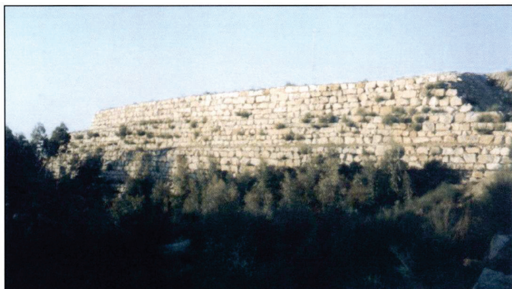
Foto 4 - Vista da zona de aterro murada virada a poente, que protege visualmente as áreas de britagem e de depósitos de estêreis.
